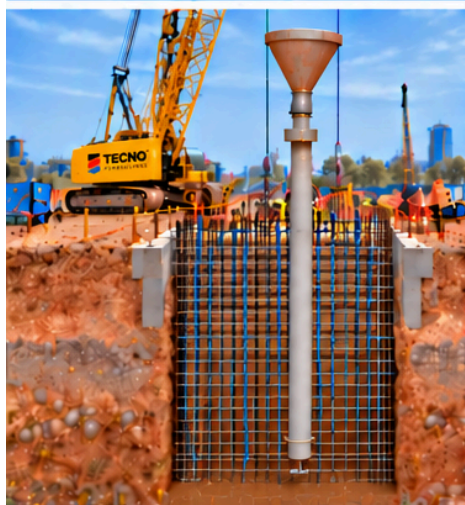
05 · Instalación de tremie
