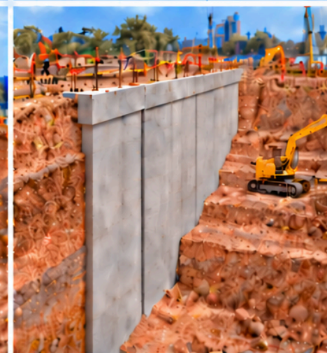
08 · Coronamiento y excavación
