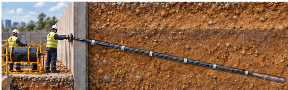
02 • Colocación del tendón
